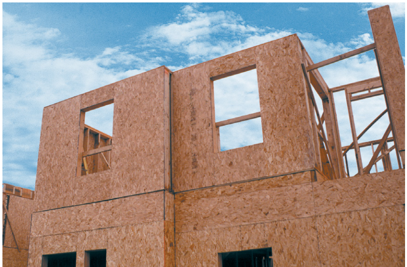
El OSB tiene capacidades de rigidización de las esquinas y mayores valores estructurales.
