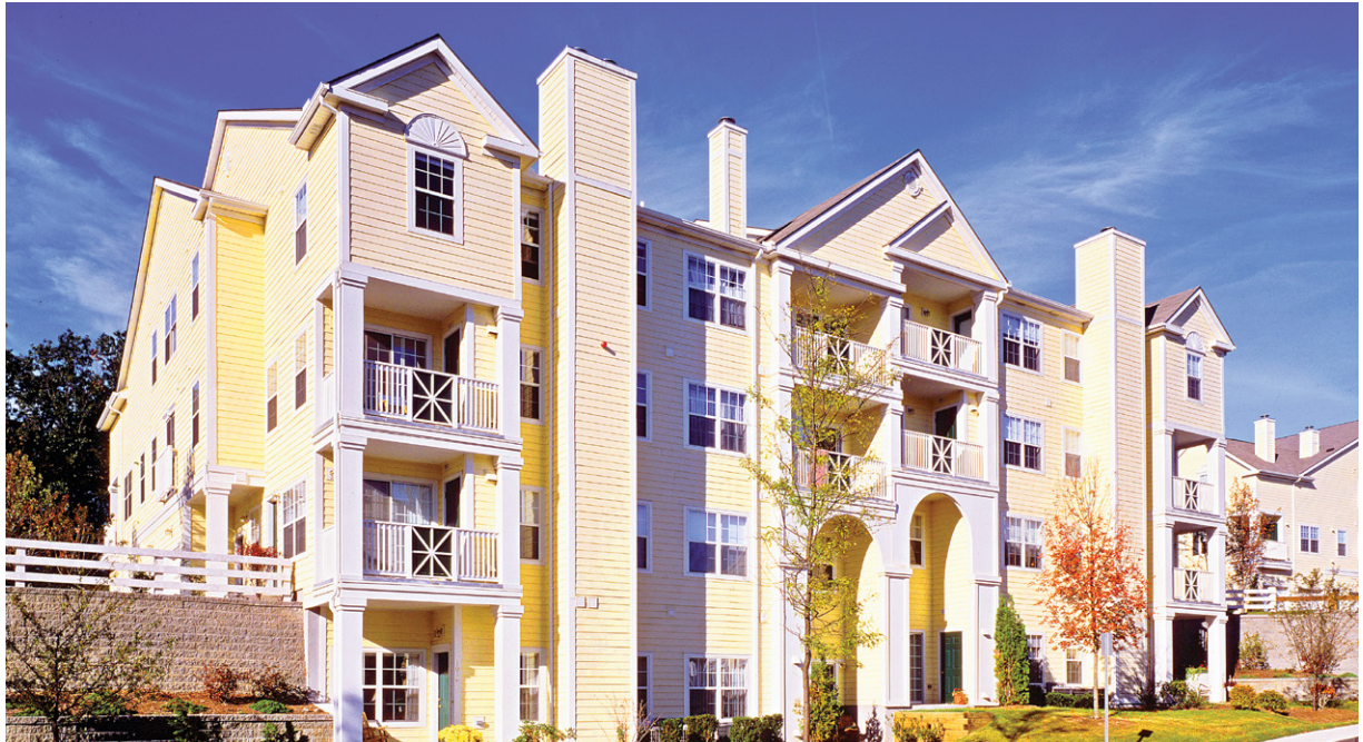
El proyecto de condominio de diez edificios, de 210,000 pies cuadrados emplea tableros de revestimiento de muros OSB que ostentan el sello de APA.
