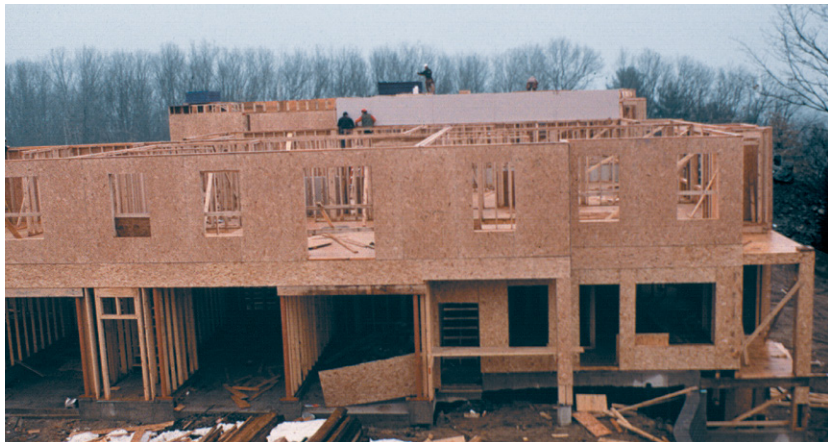
La consistentes cualidades del OSB reducen el desperdicio en la construcción y las quejas sobre los productos.
