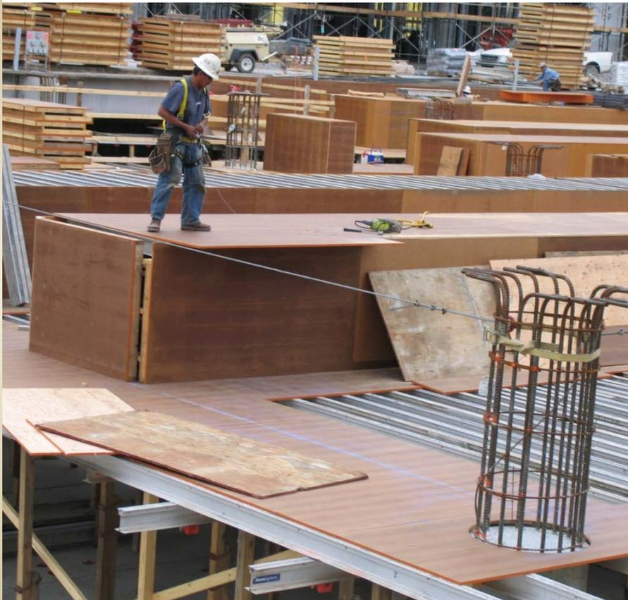
Los revestimientos MDO y HDO proporcionan una superficie durable a los paneles. Los revestimientos resisten la penetración de la mayoría de los agentes químicos y crean un acabado duro e impermeable contra el impacto, un buen ejemplo es cuando se cuela concreto en los paneles. Estos paneles de molde se pueden utilizar para realizar varios colados.
