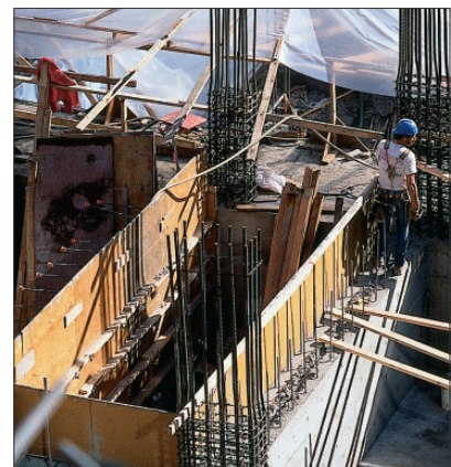
Los paneles HDO pueden re-usarse muchas veces en cimbras de concreto
