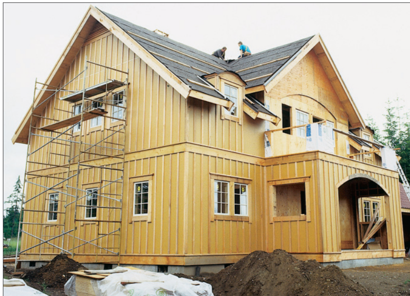
El recubrimiento exterior con capas de fibras resistentes está disponible con superficies ranuradas o lisas.
