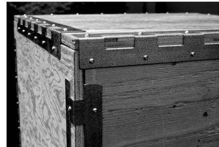
El nuevo herraje diseñado por la APA aumenta la resistencia y durabilidad de los contenedores al tiempo que permite ensamblarlos y colapsarlos fácilmente (patente pendiente).
